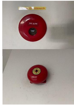
รูปที่ 33 กริ่งสัญญาณเตือนภัย (Alarm Bell) และเครื่องแจ้งเหตุโดยใช้มือดึง (Fire Alarm Manual Station)
