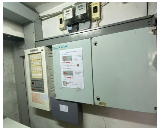
รูปที่ 31 แผงควบคุม (Fire Alarm Control Panel : FCP)
