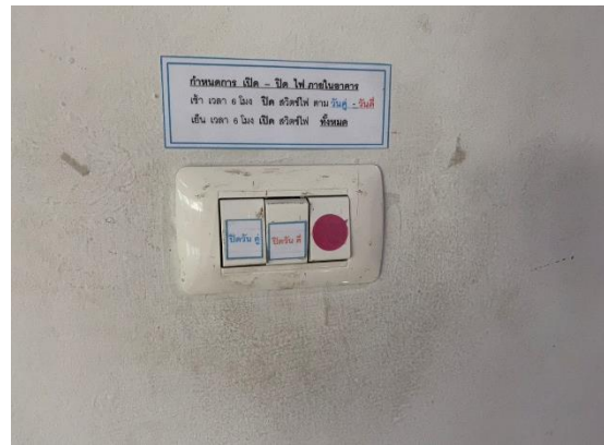
รูปที่ 21 แยกสวิตช์ควบคุมอุปกรณ์ไฟฟ้าแสงสว่าง
